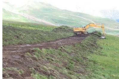
Carte 2 Exemple de stockage de mottes à la pelle mécanique en bordure d'emprise
