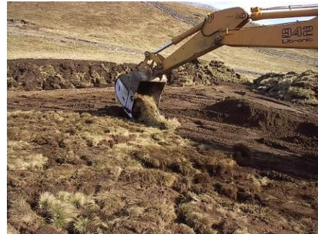
Carte 3 Exemple de remise en place de mottes à la pelle mécanique
