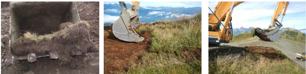
Carte 1 Exemple de déplaquage de mottes à la pelle mécanique et godet « classique »
