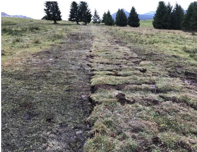
Etrépage- : résultats de replaquage sur de travaux de réseaux sur le plateau des Gilères (photos 2019 année des travaux)
