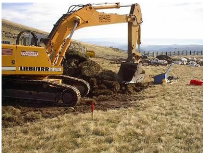
Carte 2 Exemple de stockage de mottes à la pelle mécanique en bordure d'emprise
