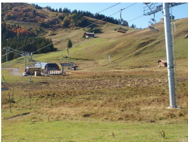
Etrépage-Résultats de replaquage sur de travaux de réseaux sur le domaine skiable du Giffre-Samoens (photo 2019, année des travaux)
